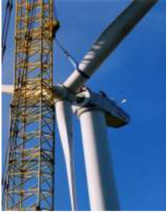
Монтаж вітроагрегату Turbowinds T600-48
